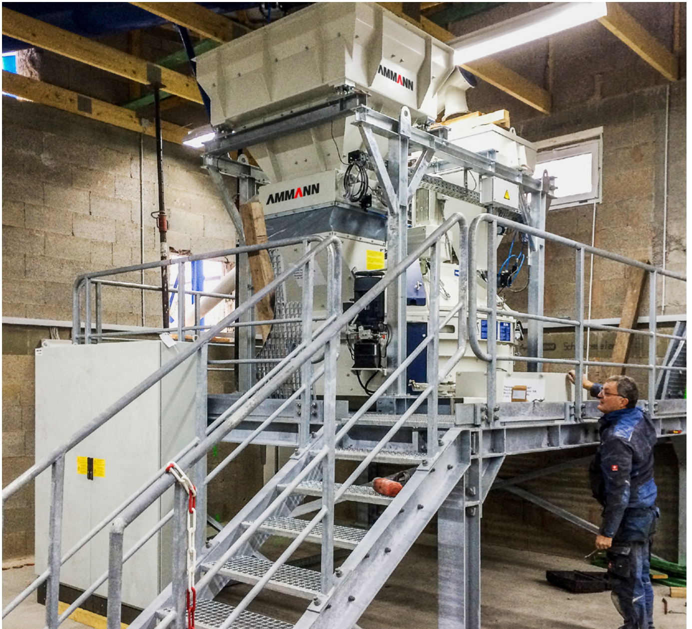
Módulo CMP B, CEM 750 P Elba durante el montaje.
