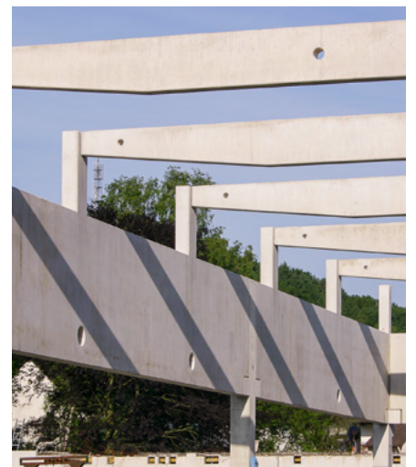
Vigas y soportes de hormigón armado
