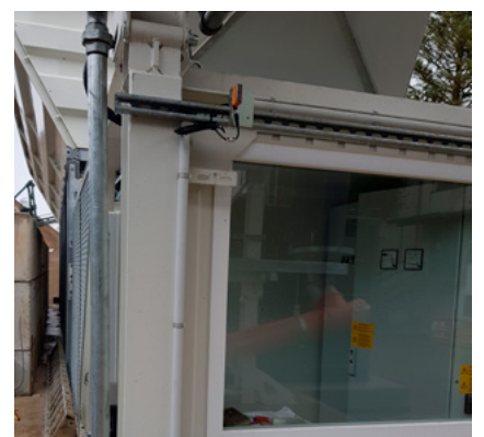
Opcional: Detección de altura de vehículos para el control del embudo giratorio.
