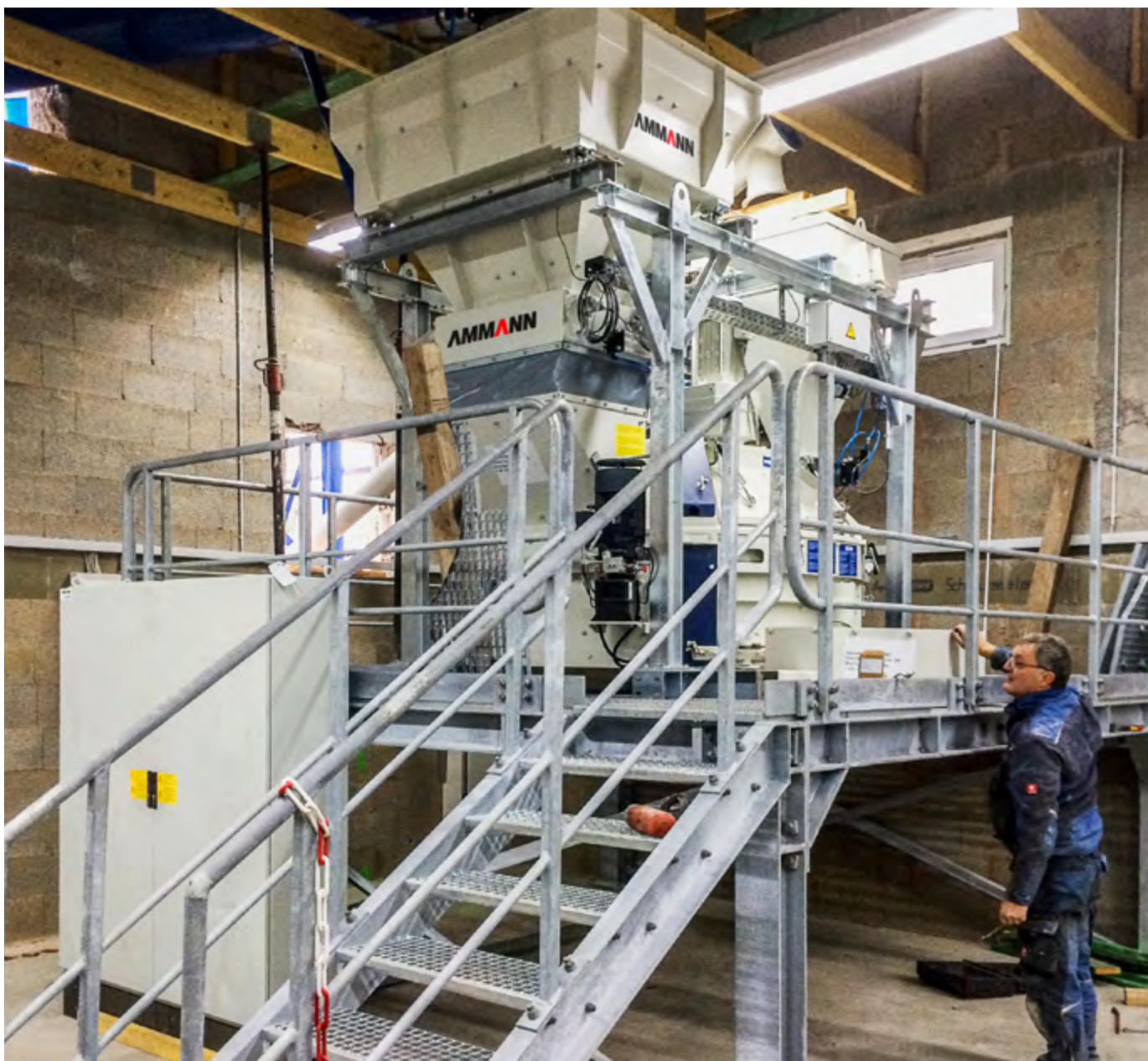
Module CMP B, CEM 750 P Elba pendant l'installation.
