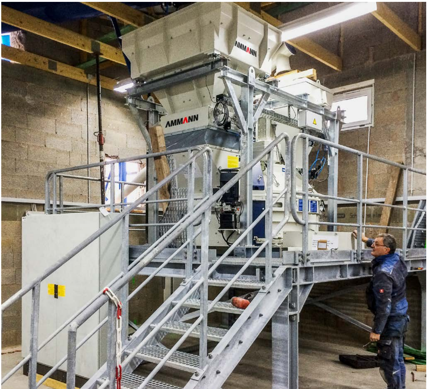
Modul CMP B, CEM 750 P Elba während der Montage.
