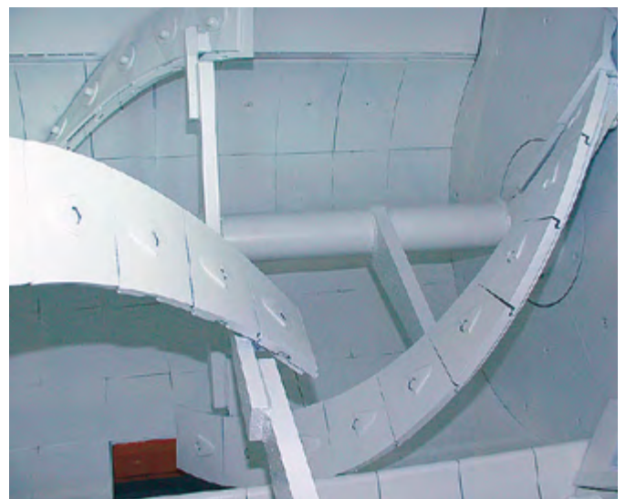
Habillage de la cuve avec des dalles d'usure autobloquantes brevetées.
