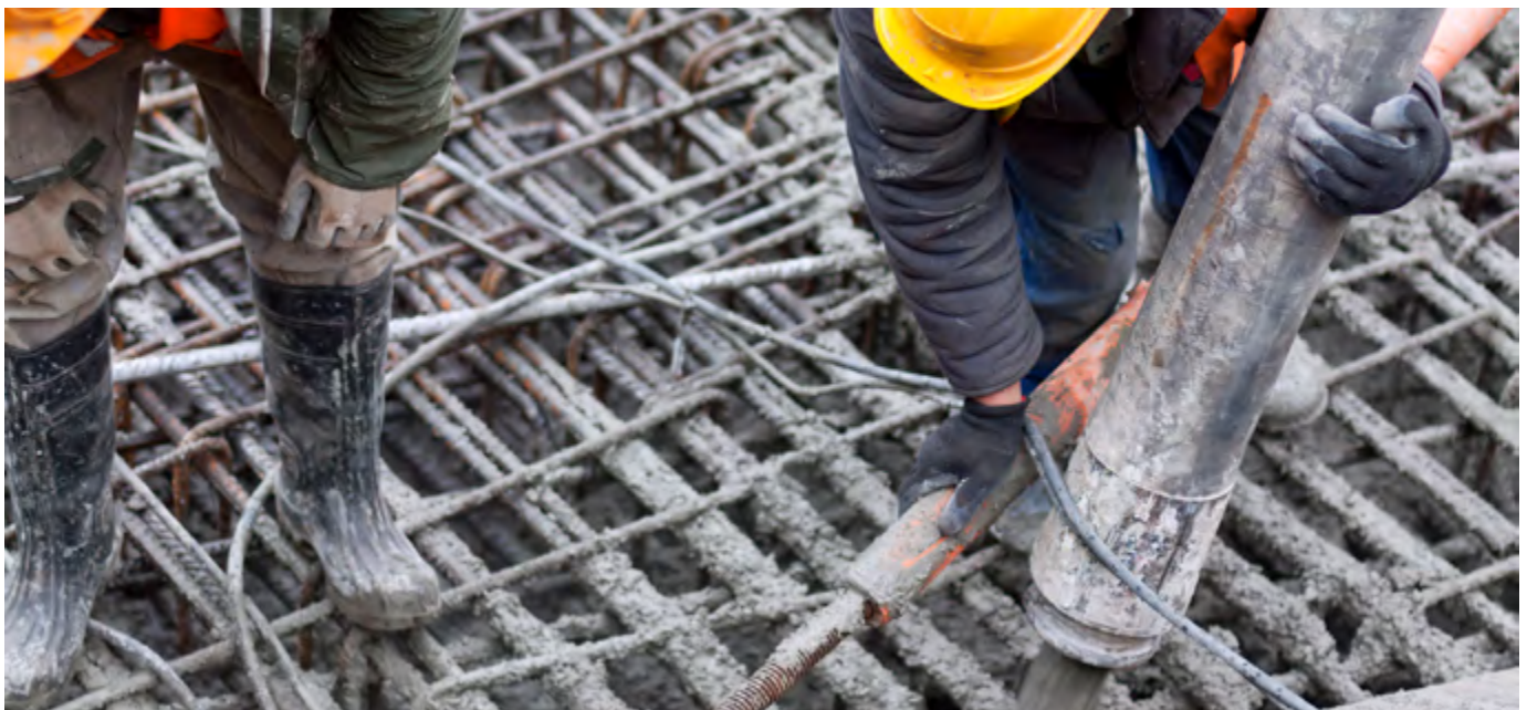
Typischer Einbau von Transportbeton.
