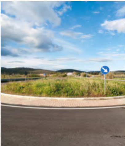
KREISVERKEHR AUS BETON
