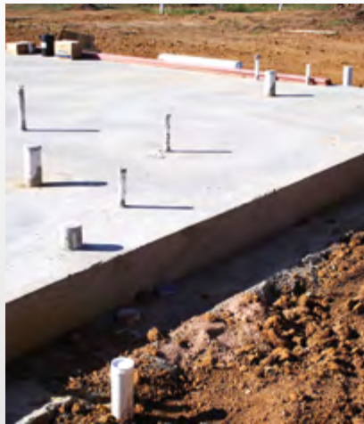
FUNDAMENTE AUS BETON
