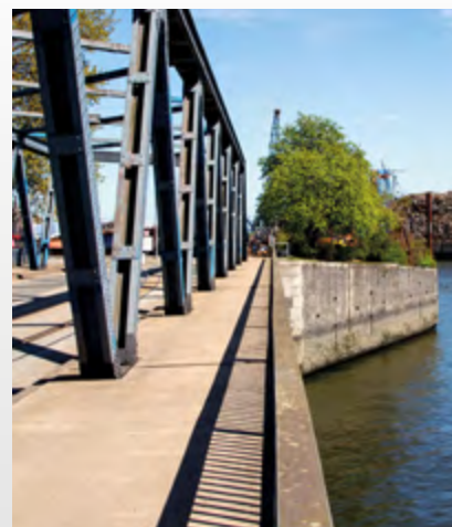
COSTRUZIONI DI PORTI
