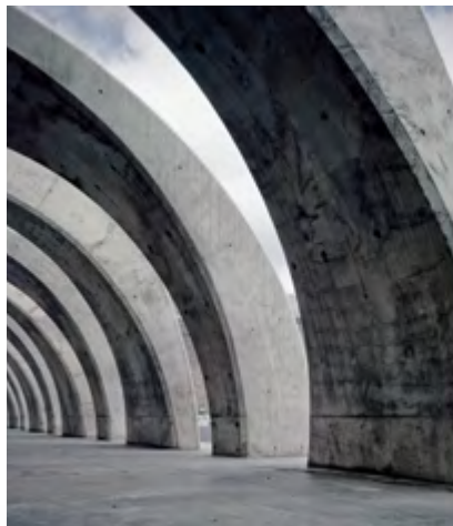
COSTRUZIONI DI PORTI
