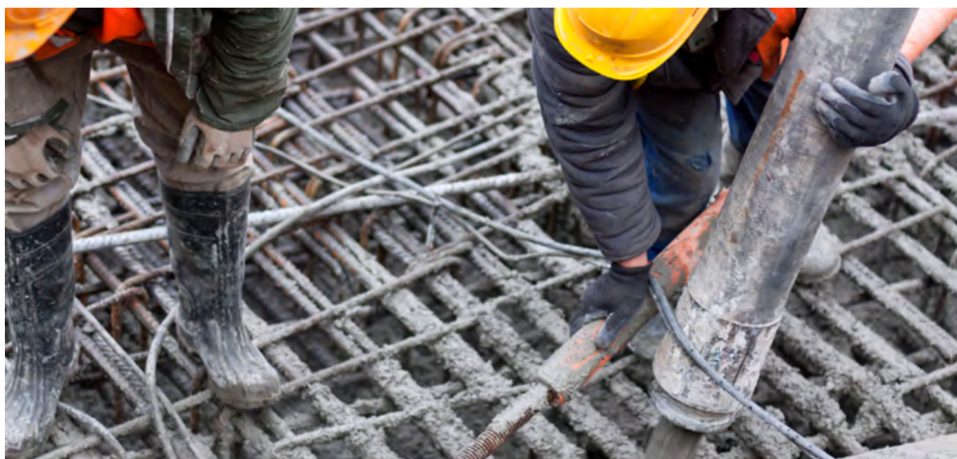
Tipico impiego di calcestruzzo da trasporto.
