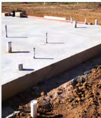
FONDAMENTA IN CALCESTRUZZO
