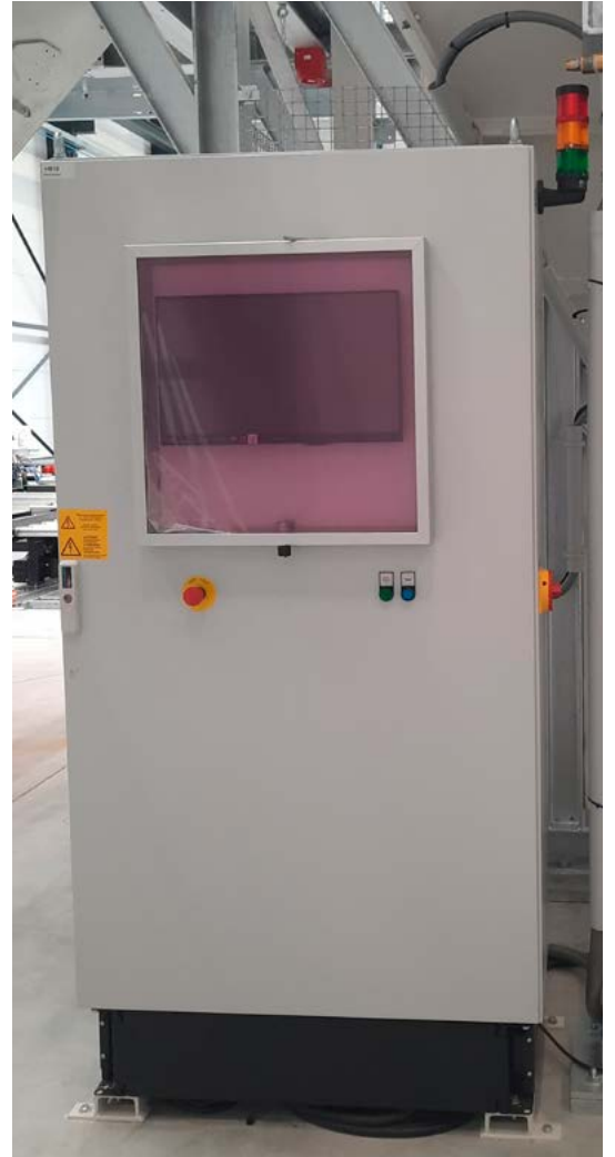
Feux de signalisation pour l'accès à la centrale, Utilisation d'un écran tactile, en option l'adjonction d'adjuvant.
