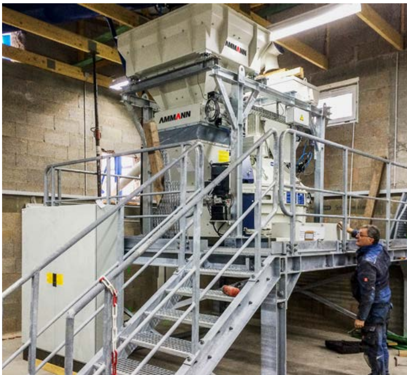
Modulo CMP B, CEM 750 P Elba in fase di montaggio.
